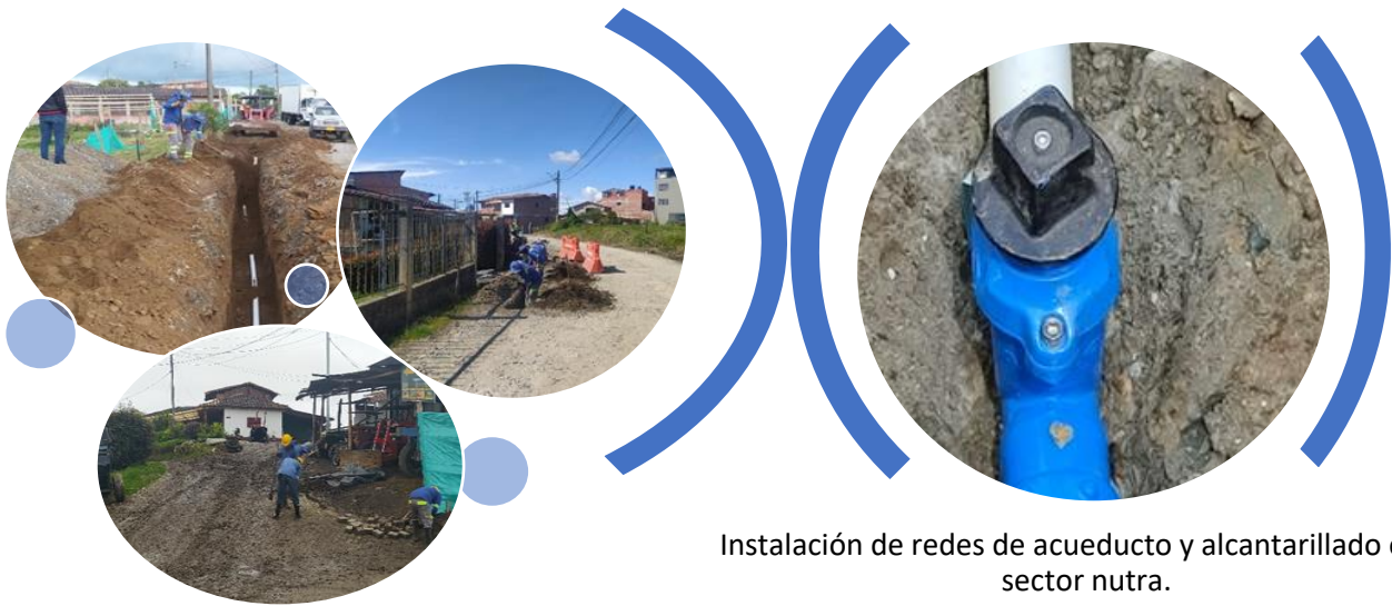
Cambio de 06 válvulas en el sistema de acueducto en la Carrera 09 con calle 09, carrera 07 con calle 12, calle 15 con carrera 10, calle 15 con carrera 11.
